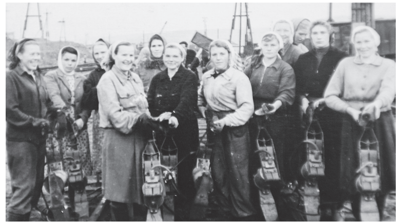
Комсомолки из Боровичей на строительстве железной дороги Москва — Никель, конец 1950-х годов. В руках у девушек — электрические шпалоподбойки, Нина Мурашова — первая слева
